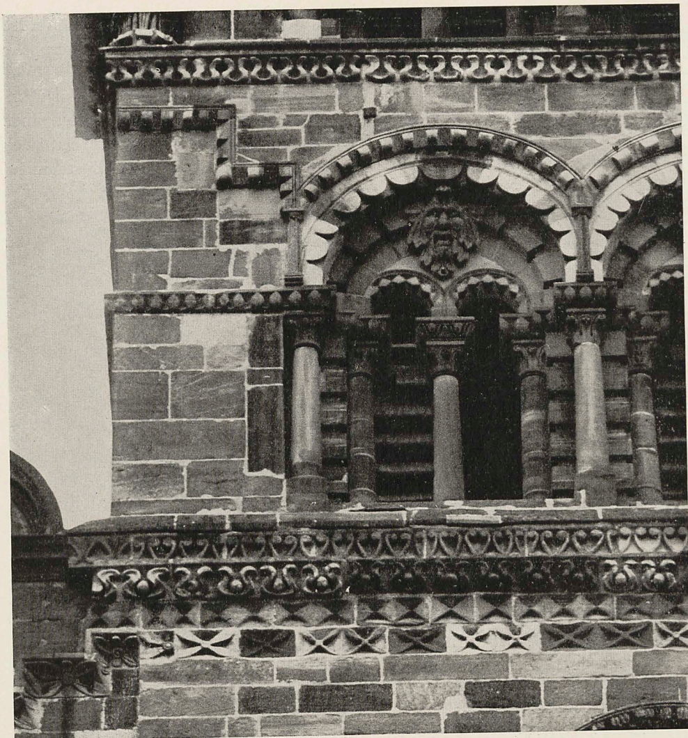
Abb. 4. Trierische Bauzier. St. Matthias in Trier, Einzelheiten vom Westturm.
