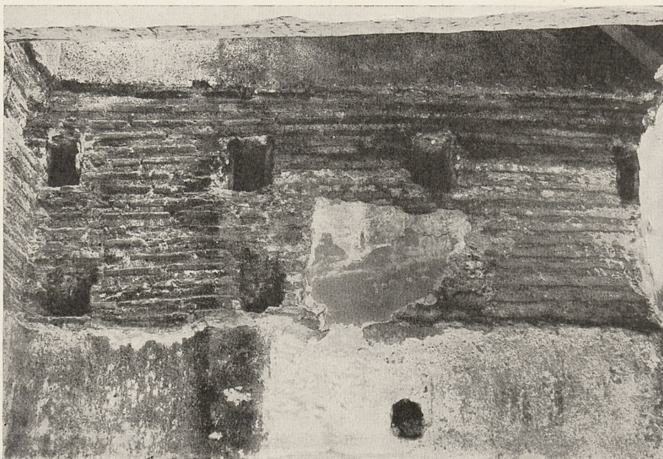
Abb. 7. Leerstreifen im Verputz der Apsis (NO-Ecke) mit Balkenlöchern zur Anbringung einer Holzgalerie.
