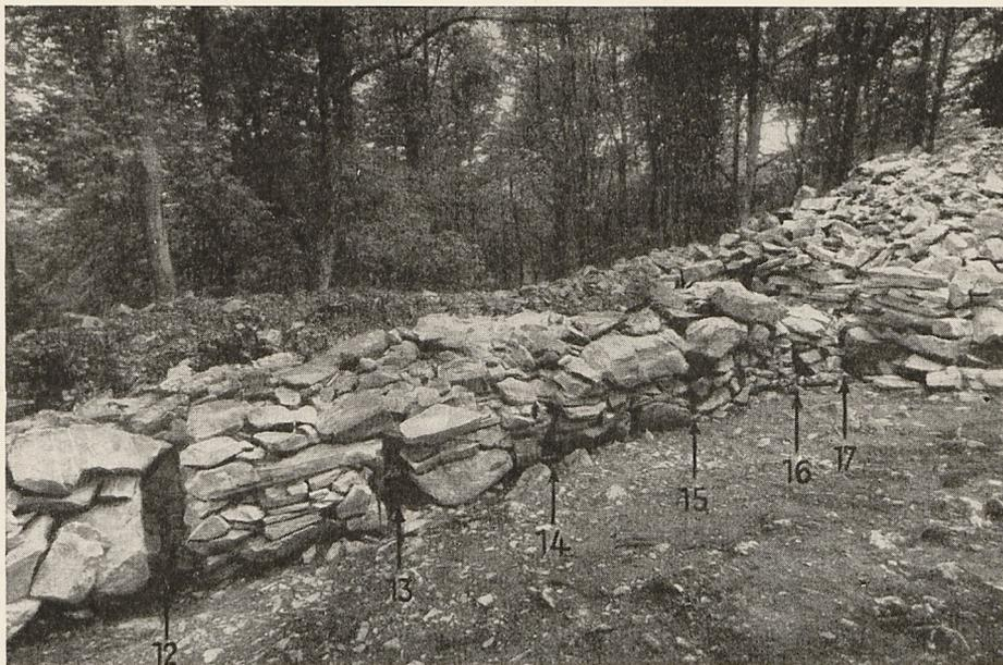
Abb. 5. Innenfront der Rampenmauer mit Pfostenschlitzen.
