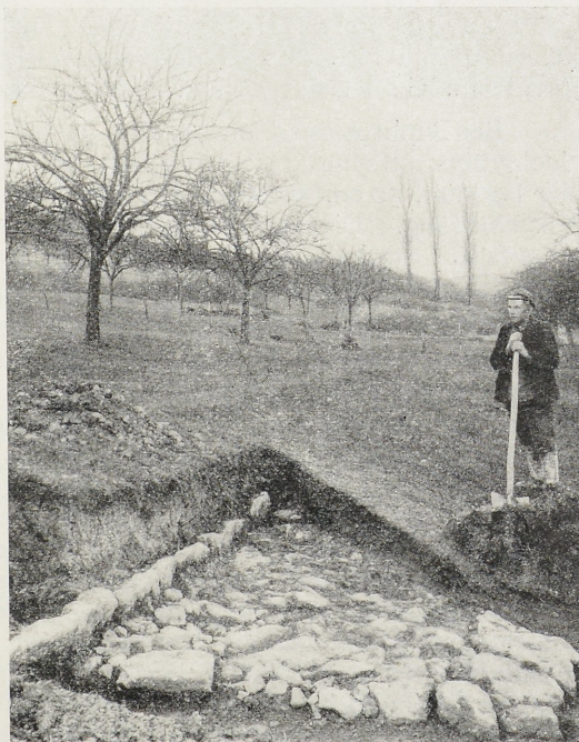
Abb. 8. Straße mit Randsteinen von W. nach O. gesehen. (im Hintergrund bei den 3 Pappeln die Villa).
