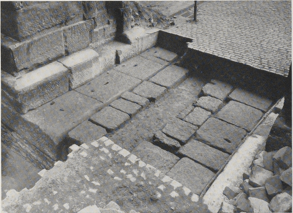
Abb. 19. Quaderlage in der westlichen Tordurchfahrt der Porta Nigra auf der Landseite.
