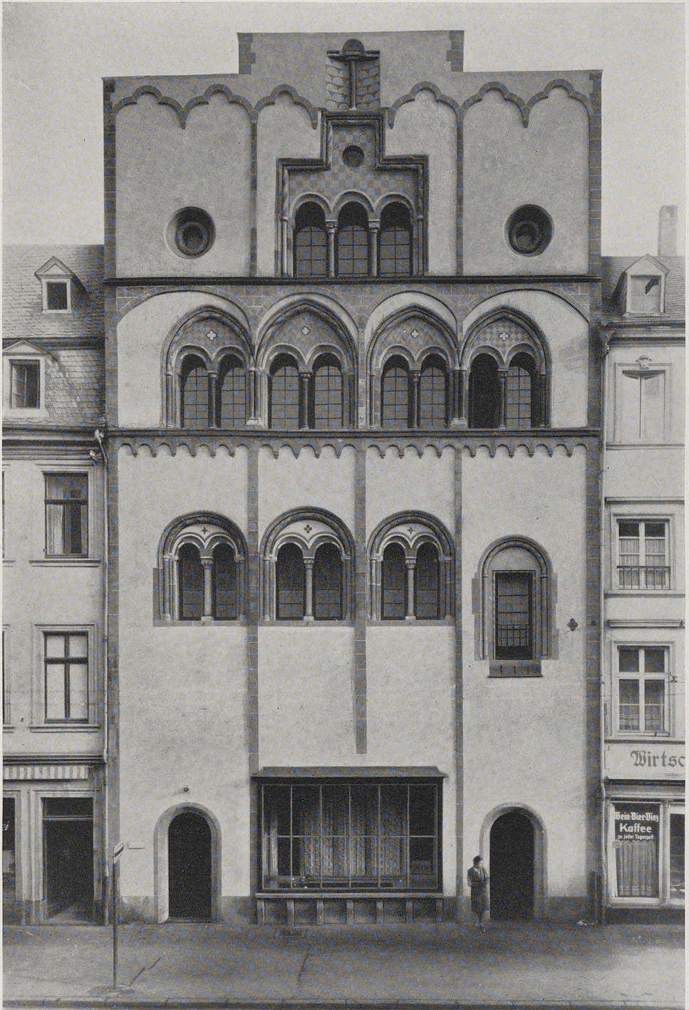
Abb. 43. Das Dreikönigenhaus in Trier nach der Instandsetzung.
