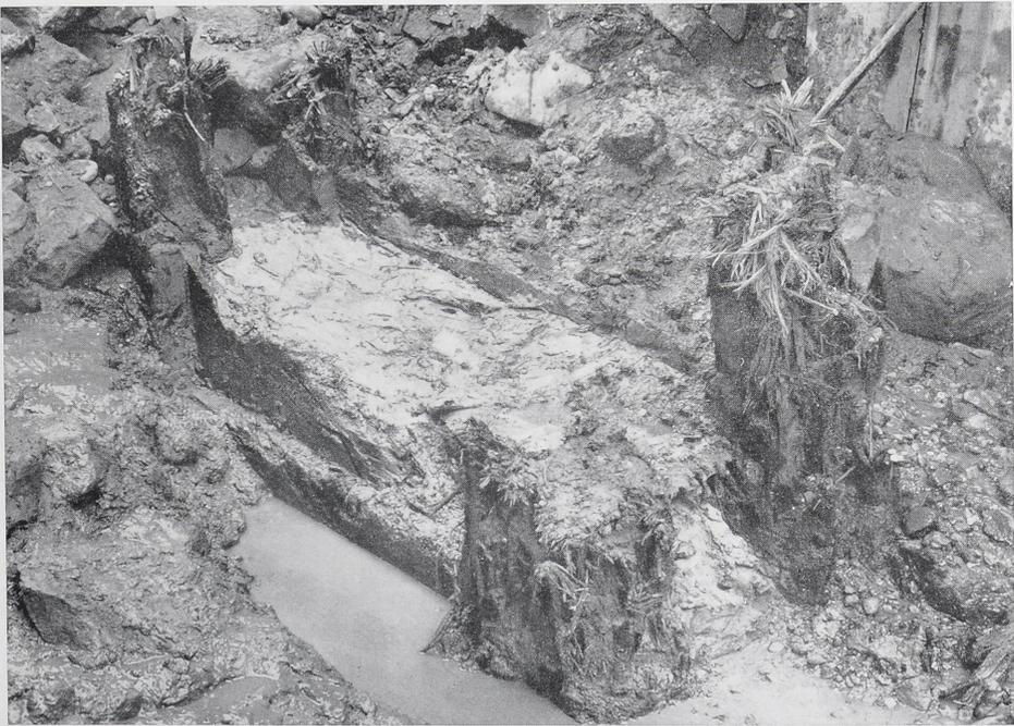
Trier, Römerbrücke. Oben: Pfeiler 3. Blick auf den senkrecht geschnittenen Spundkasten; in der Bildmitte die helle Dichtungsmasse, eingefasst rechts und links von Bohlen; die linke Bohle steckt noch sichtbar in der Nut des dunklen Pfostens. — Unten: Pfeiler 3. Blick auf einen Teil des römischen Spundkastens. Im Vordergrund rechts zwei dunkle Eichenpfosten, zwei entsprechende im Hintergrund links, dazwischen die helle Dichtungsmasse zwischen Bohlen eingebettet.
