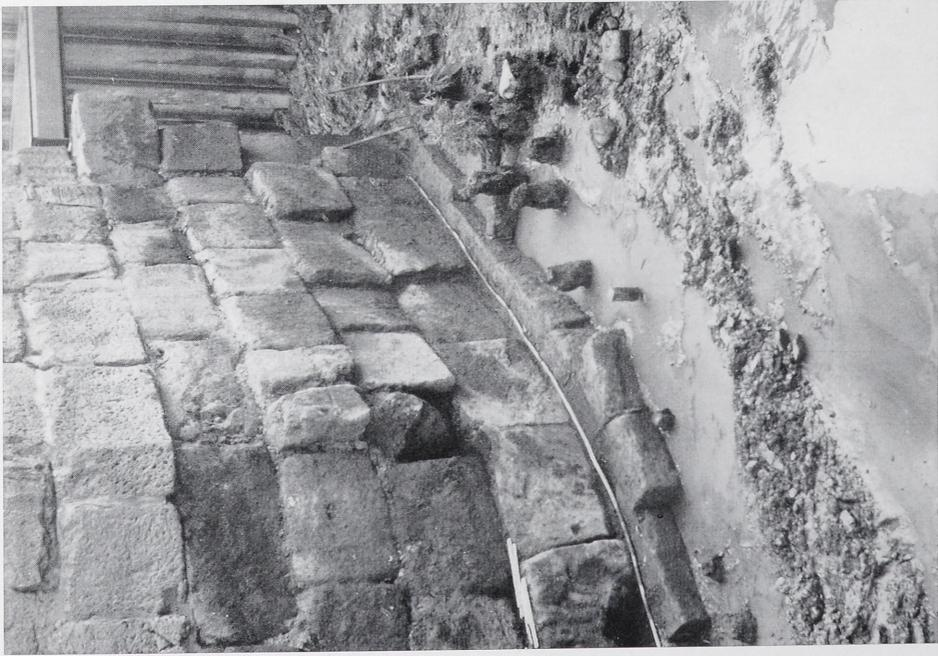
Trier, Römerbrücke. Links: Pfeiler 3. Blick auf die Holzpflähe unmittelbar neben dem Pfeilerfundament. — Rechts: Pfeiler 3. Blick stromab auf das rechteckige Fundament mit dem abgerundeten Pfeiler darauf
