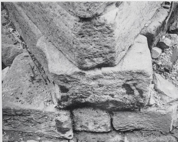
Trier, Römerbrücke. Oben: Pfeiler 2. Blick stromab auf die Pfeilerspitze. Die unteren Lagen sind durch die Auskolkung abgesackt und teilweise weggebrochen. — Unten: Pfeiler 4. Blick stromab auf die keilförmige Pfeilerspitze, deren Fundierung nach unten immer breiter wird
