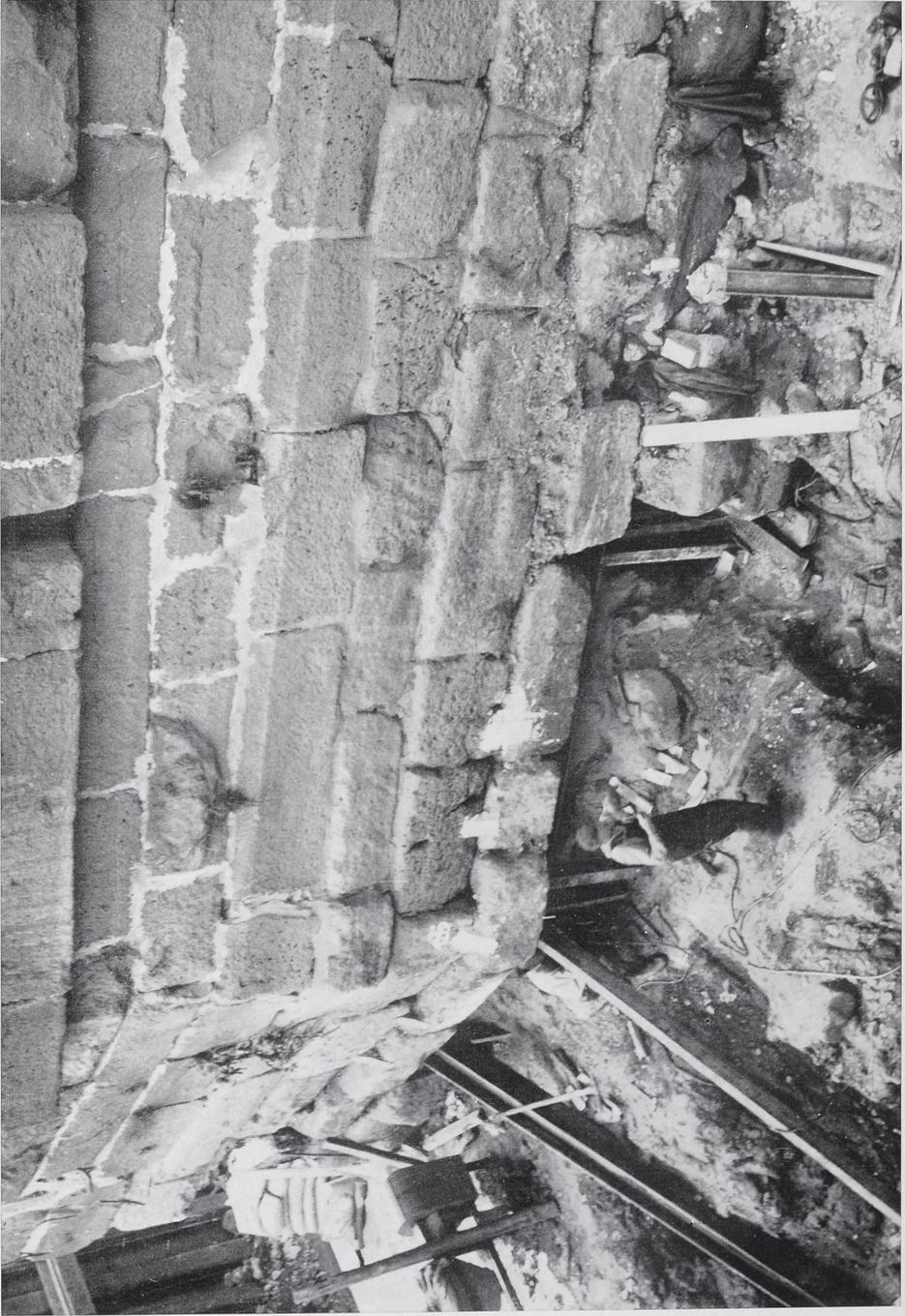
Trier, Römerbrücke: Pfeiler 2. Blick auf die Ostseite. Die unteren Quaderlagen sind teilweise durch die Strömung ausgespült.
