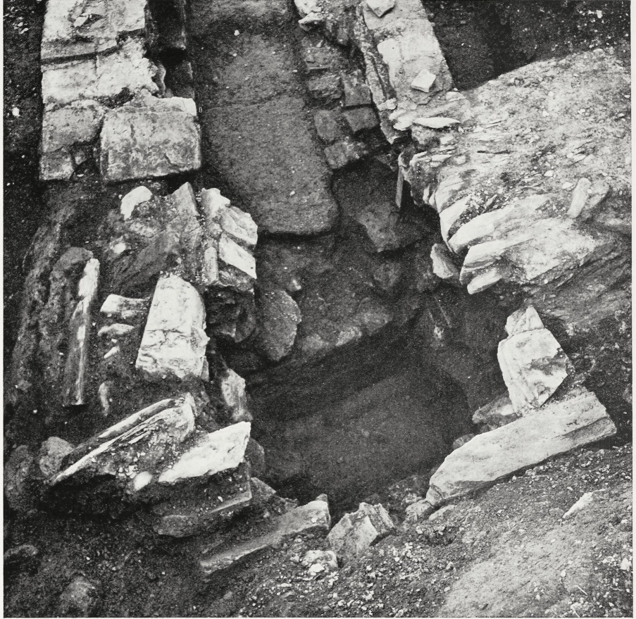
Abb. 5 Einmündung des unteren Zulaufs N in den Hauptkanal M mit Ansatz eines Schachtbauwerks vorne rechts (Lage vgl. Abb. 1)
