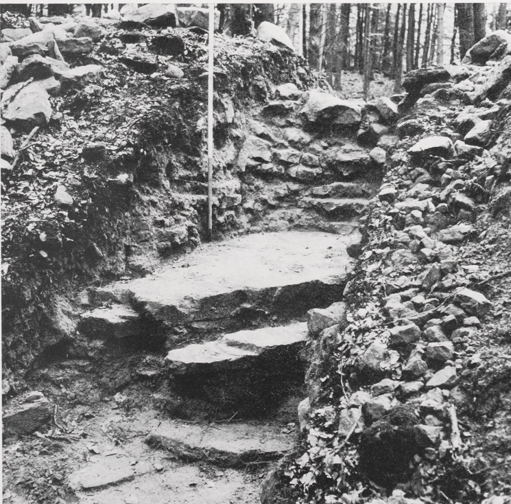
Abb. 5 Niederburg Bollendorf, frontaler Mauerkern und stufenförmige Berme im Schnitt IV, von Nord
