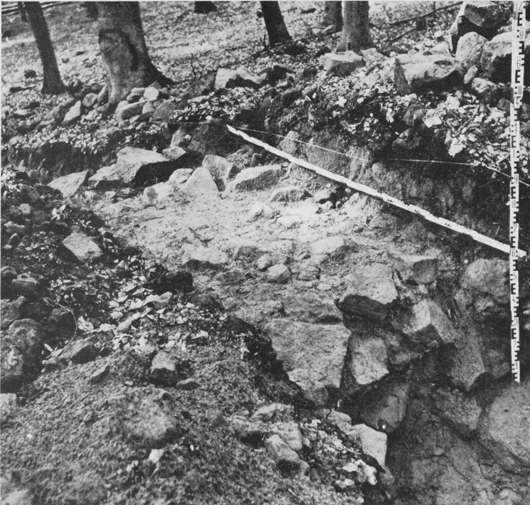
Abb. 4 Niederburg Bollendorf, Mauerkern im Schnitt III, von Südwest
