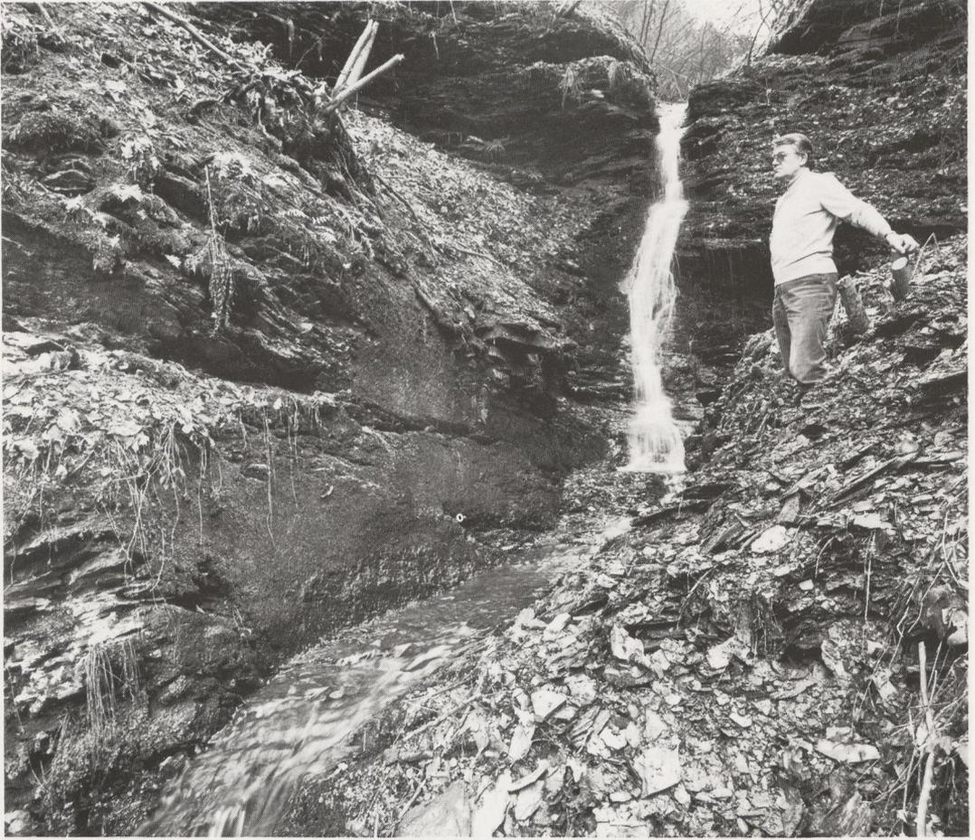
Abb. 5: Untere Mühle, Blick von Nordost. Links Felsabschrotungen der Radrinne, daneben teilweise ausgebrochene Schußrinne. – Foto LM. Trier RE. 83, 14/4
