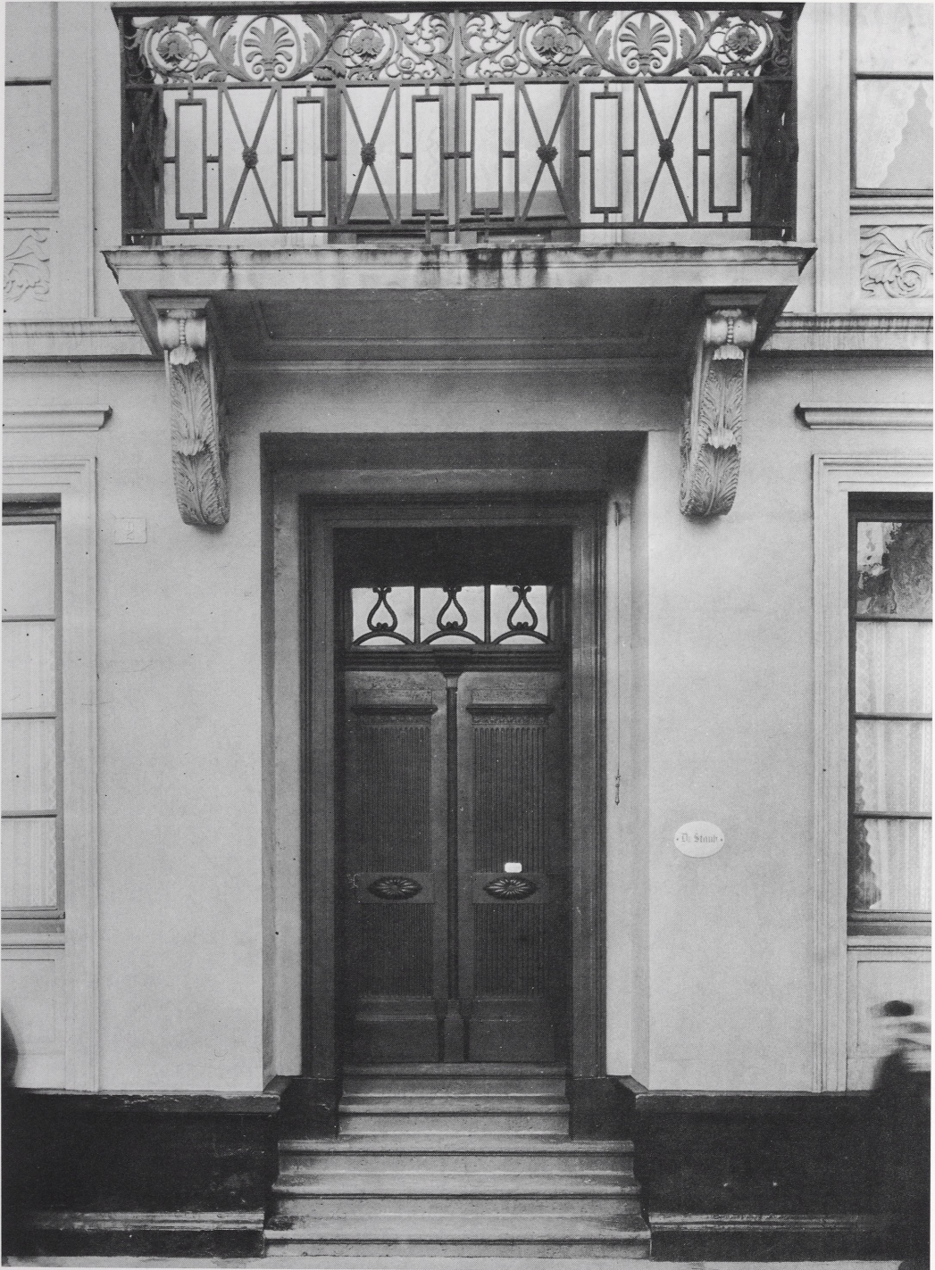
Abb. 7 Trier, Antoniusstraße 2. Hauseingang mit Balkon (Aufn. Deuser um 1906)
