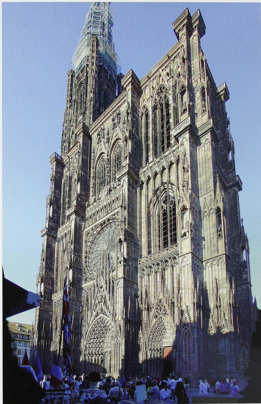
Abb. 11 Straßburg, Münster. Ansicht von Südwesten.
