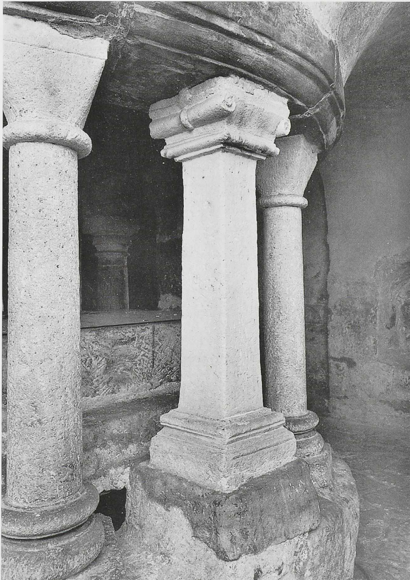
Abb. 14 Quedlinburg, St. Wiperti, Pfeilerchen hinter dem Hauptaltar der Krypta von Südosten
