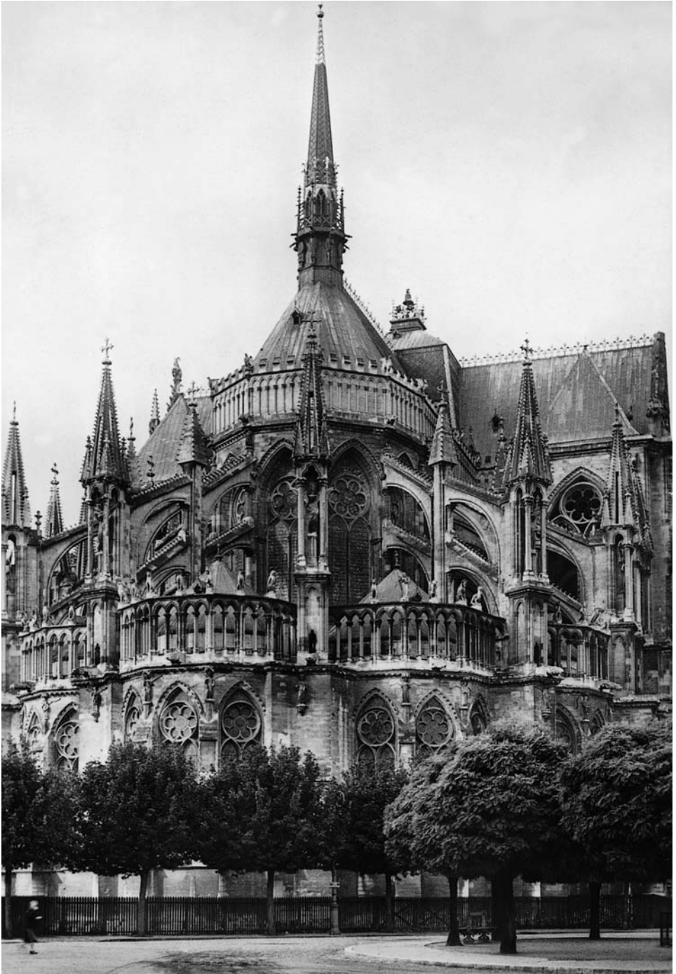
4 Reims, Kathedrale, Äußeres des Chors
