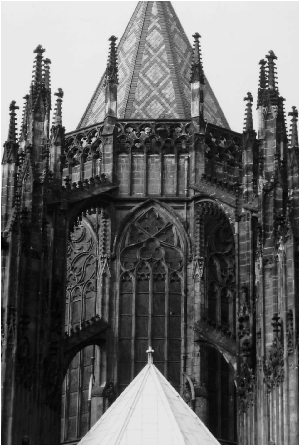
7 Prag, Veitsdom, Blick auf den Obergaden des Chorhaupts
