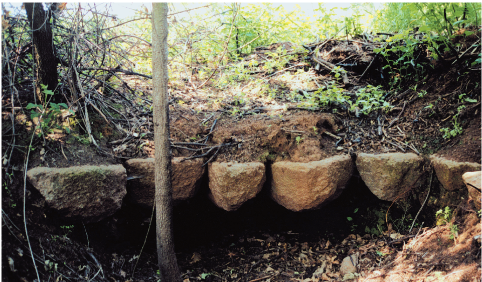
Abb. 6 Nachantike, das römische Pflaster begleitende Straßen graben sich allmählich zu Hohlwegen ein: so erscheint das kompakt gebliebene Pflaster stellenweise im Längsschnitt hoch in der Wand solcher Hohlwege (Via Amerina bei Corchiano).
