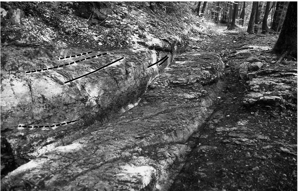
Abb. 12 Geleisestraße am Bözberg: Lineare Strukturen von älteren Trassen zeichnen sich sowohl in der bergseitigen Böschung (Abfolge lateral talwärts) als auch in der Seitenwand der bergseitigen Rille (Abfolge vertikal) ab.
