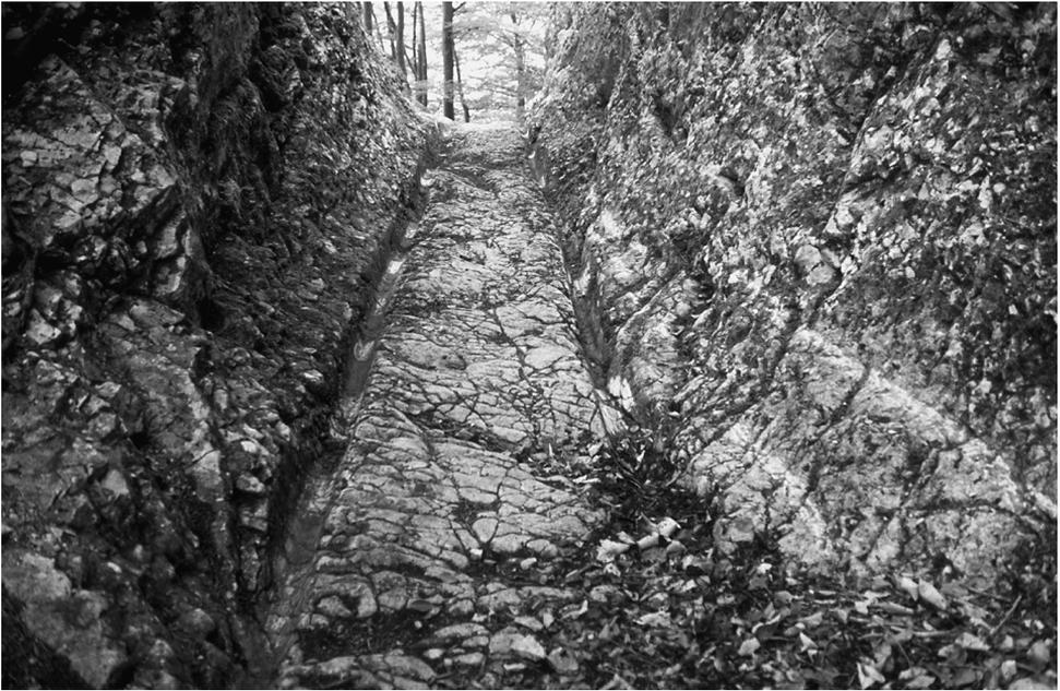
Abb. 11 Felseinschnitt der Geleisestraße am Oberen Hauenstein: In der Böschung rechts sind deutliche Spuren von älteren Anlagen erkennbar.
